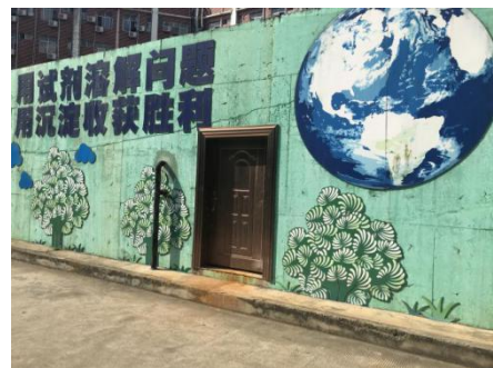
2 号污水处理站 110°24'16.36589",20°2'46.57787"
