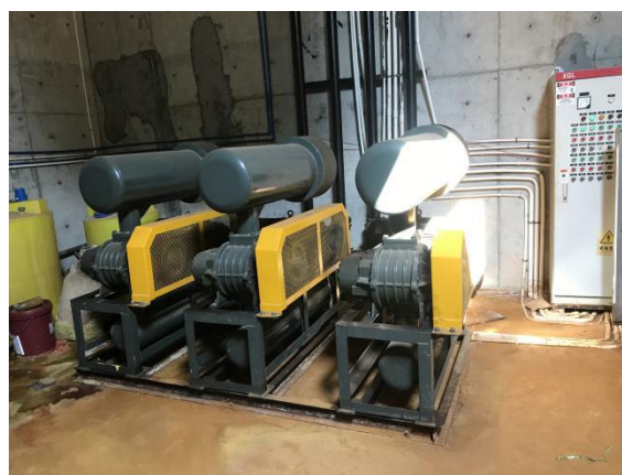
图 2-10 2 号污水处理站加药间及鼓风机
