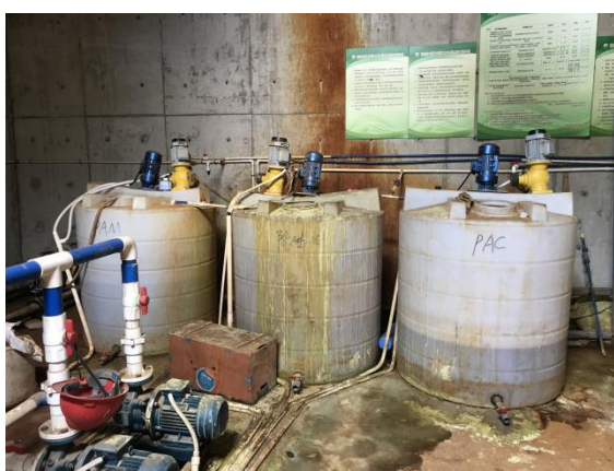
图 2-10 2 号污水处理站加药间及鼓风机
